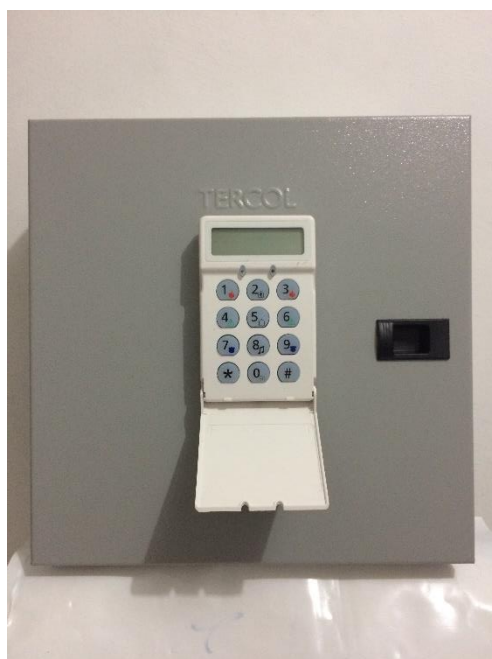
Figura 2. Caja metálica Tercol para control de llaves del Bloque 10.
