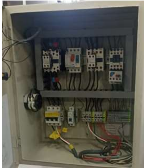
Figura 12 Sistema Eléctrico del Torno
