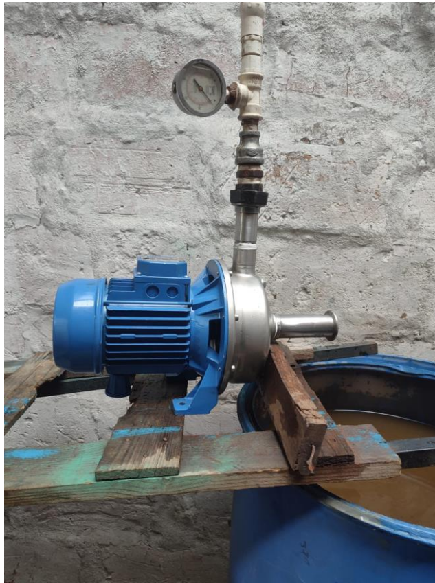
Figura 40 Banco de pruebas Fluidbombas
