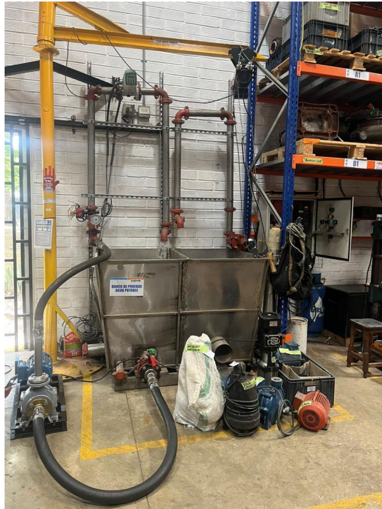
Figura 36 Banco de prueba BYR Ingeniería de fluidos Sede Medellín Fuente: Propia del autor
