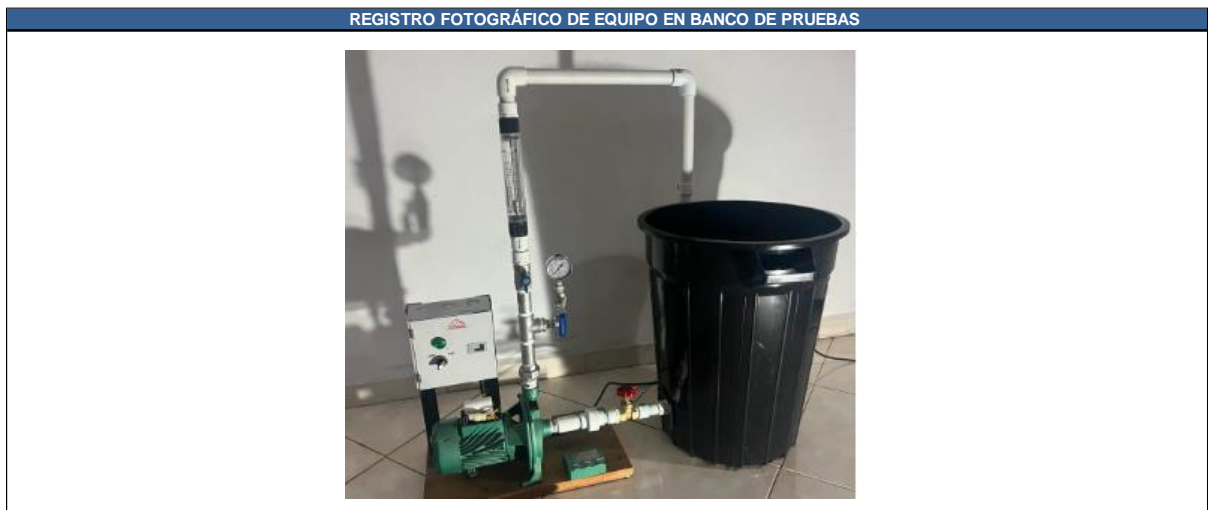
Figura 69 Bomba CPM158 instalada en banco para la prueba 1.
