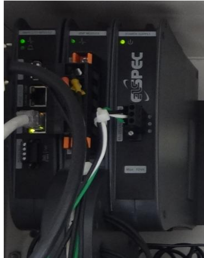
Figura 016: Los dos medidores del sistema ELSPEC de la subestación principal. - Industria de Alimentos.
