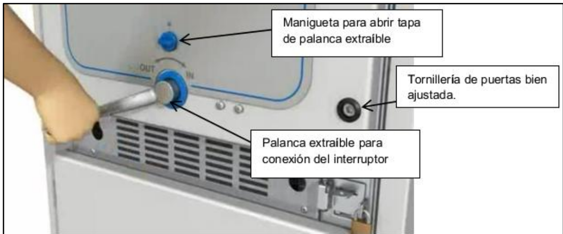
Figura 20: Mecanismo de conexión del interruptor – Con la puerta cerrada. [01]
