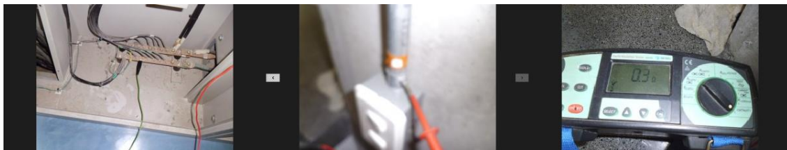
Figura 30. Medición entre tierra y tubería metálica.
