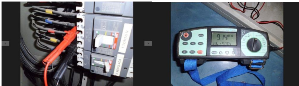
Figura 23. T. Tomas normales L2 – L3 Fuente: diseño Edwin Arbey Barbosa Barrera
