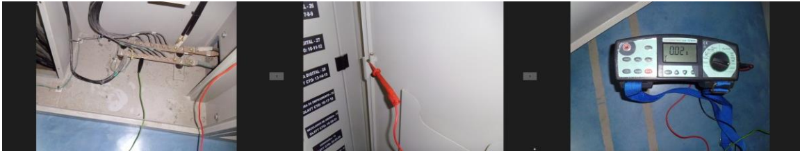
Figura 27. Medición entre tierra y compartimento del gabinete.
