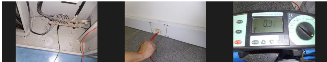
Figura 29. Medición entre tierra y polo a tierra de un tomacorriente
