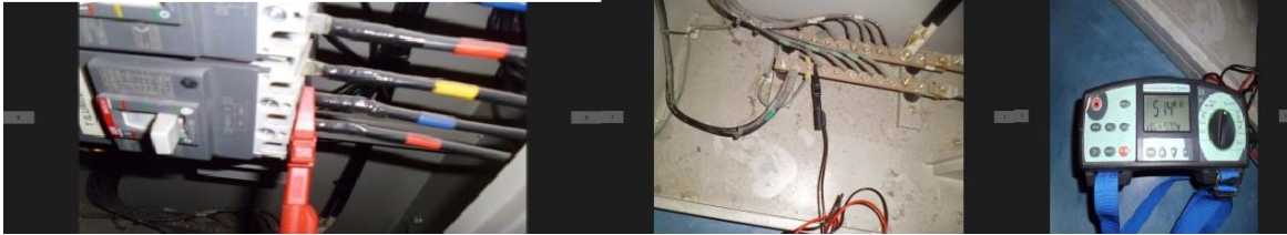
Figura 13. T. Iluminación L2 - Tierra.
