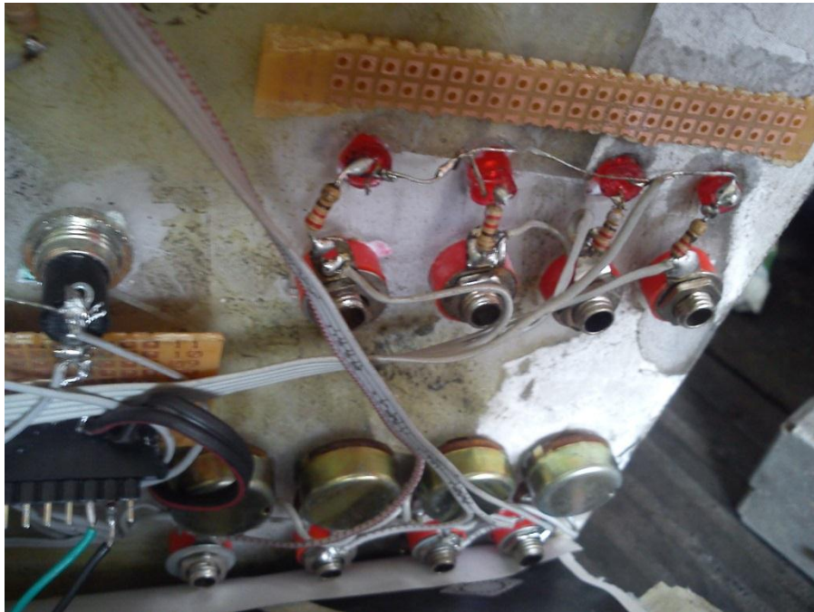
Figura 15. Imagen de la conexión de los leds y tomas de voltaje de circuito de representación los inyectores de combustible
