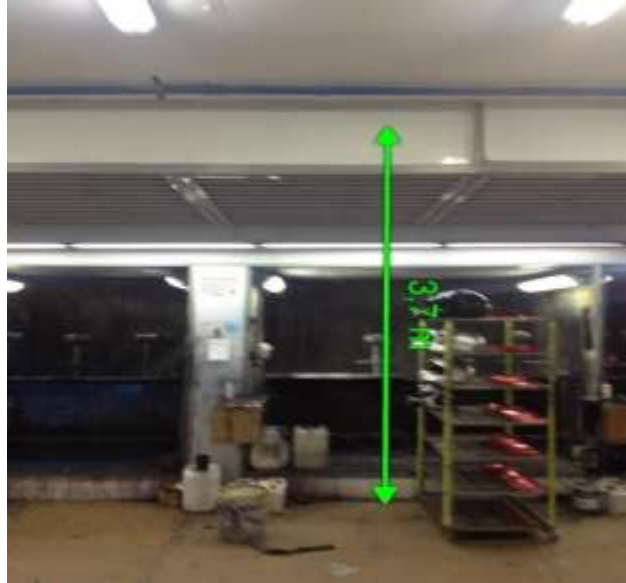
Fuente. Comercializadora INDUCASCOS S.A . FIGURA 4. Cabinas de pintura.
