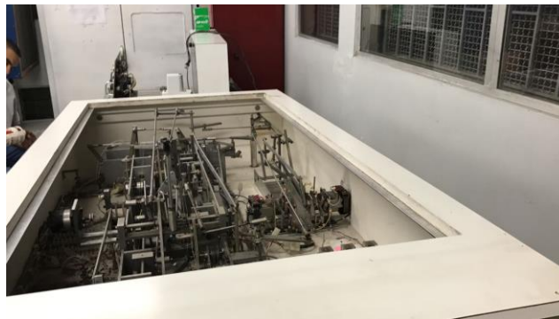
Parte de maquinaria de poleas y sensores eléctricos en primera revisión
