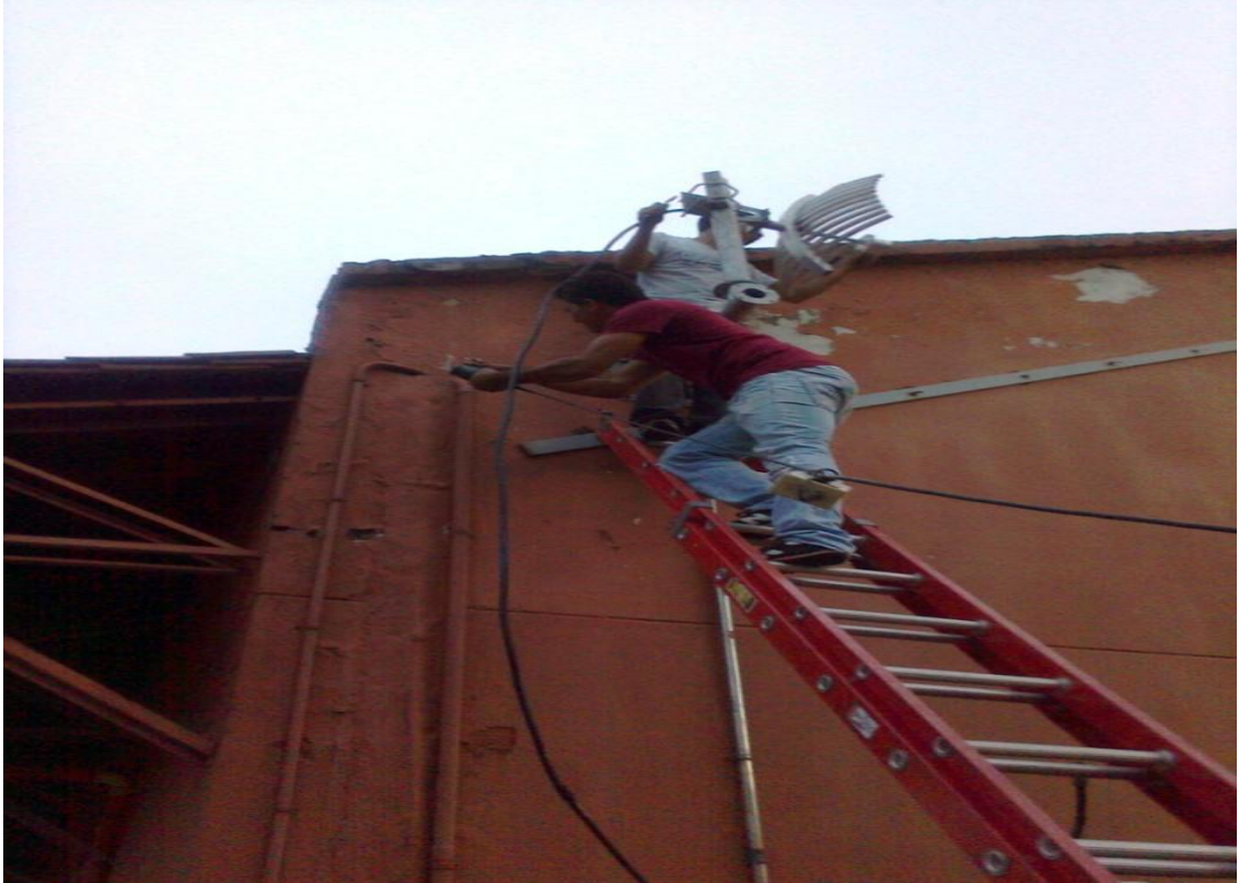
Figura 3: Instalación de antena
