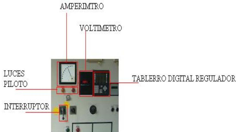
**Figura 6.** Sistema de monitoreo de voltaje y tensión
