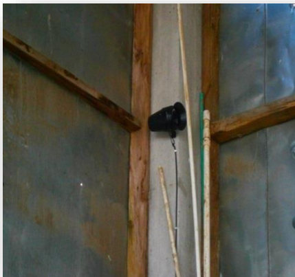
Vista interna bodega, sirena
