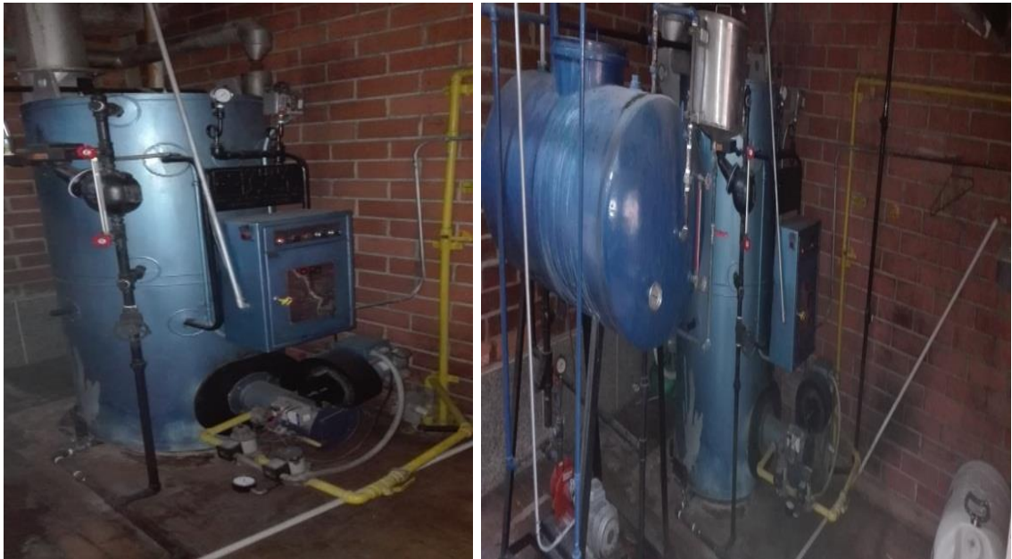
IMAGEN 1: CALDERA PIROTUBULAR
