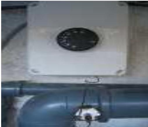
6.1.2.3 Conexiones eléctricas. En si es solo una conexión básica donde se instala una llave eléctrica de 1 polo la cual permite establecer un puente para el encendido manual cuando no hay sol o cuando la piscina excede la temperatura prefijada, también para maniobras de aspirado, lavado de filtro o para funcionamiento nocturno. En este caso si no se desea enfriar el agua se deberá abrir 100% la llave o del by-pass, a fin de que no haya circulación por los
