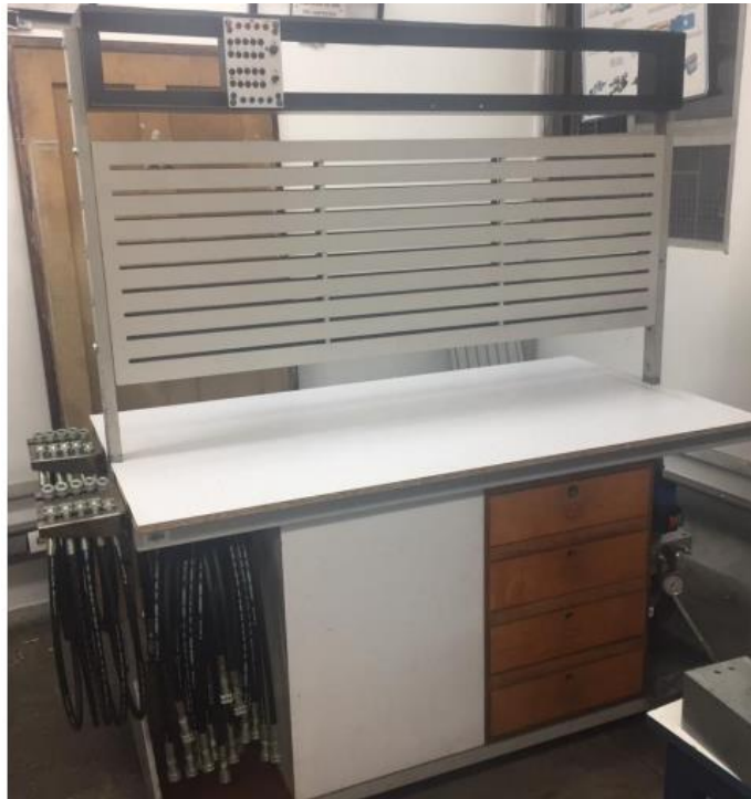
Imagen 5.2 Compartimiento con tablero control ya instalado.
