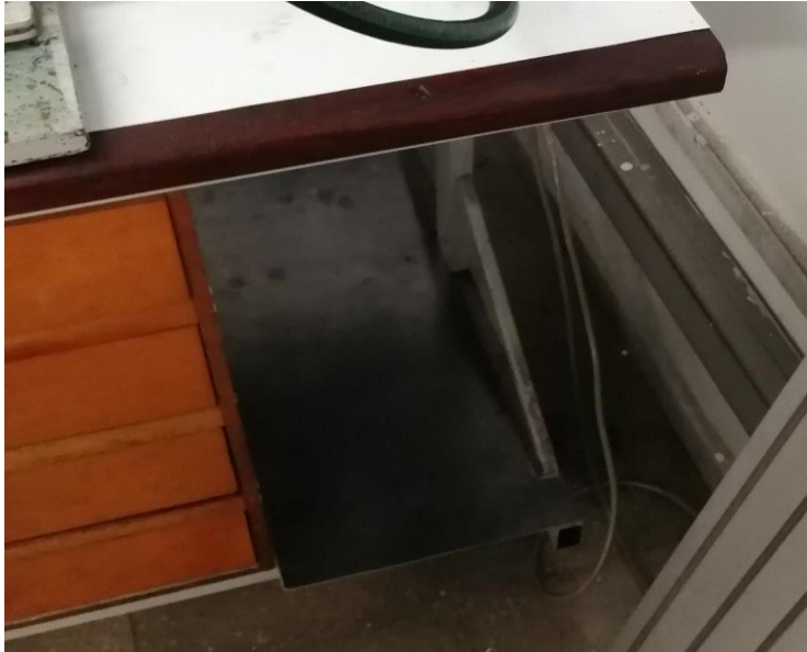
Imagen 4.2 Platina instalada para soportar bombas.
