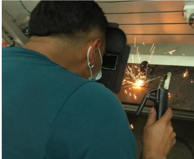
Imagen 4.5 Proceso de soldadura de ruedas a las platinas.
