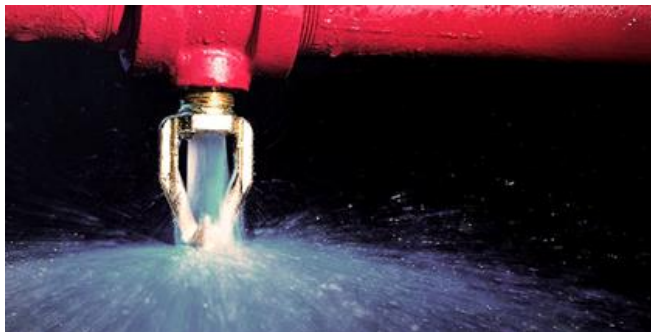
Figura 11. Aspersores contra incendios
