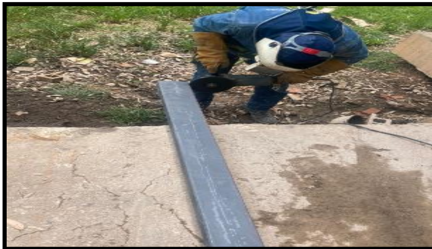
Figura 2. Corte de estructura
