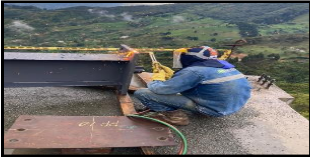
Figura 3. Reparación de perforaciones en anclajes de la columna
