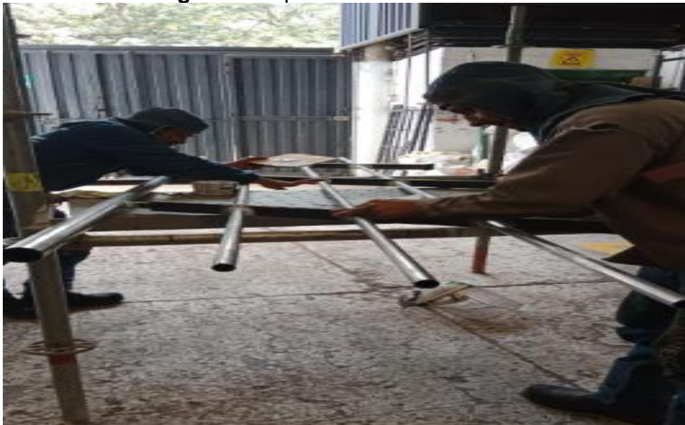
Figura 20. Aplicación de masilla a estructura
