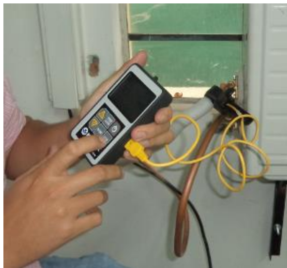
Fuente: Práctica laboratorio refrigeración registro fotográfico.
