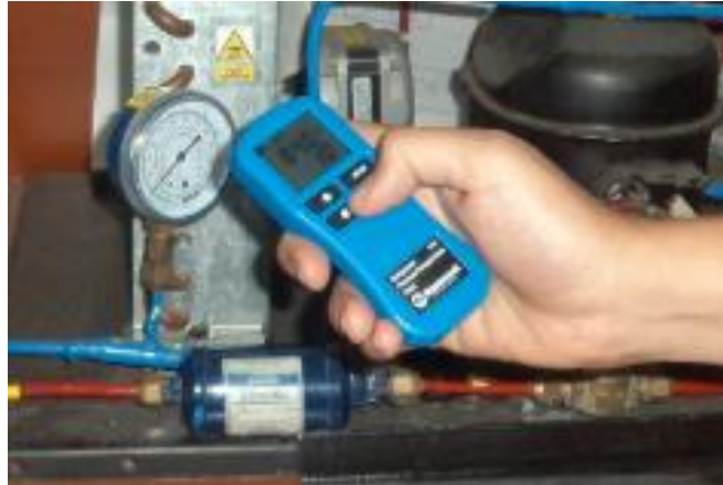
Figura 22. Practica operación carta digital presión/temperatura 52245 laboratorios de refrigeración IUPB.
