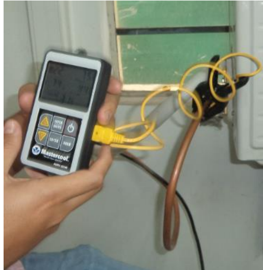
Fuente: Práctica laboratorio refrigeración registro fotográfico.
