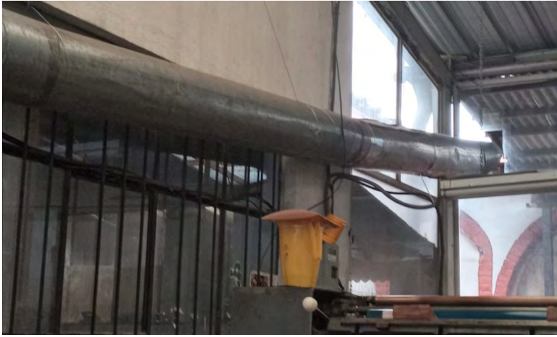
Foto 2. Desfogue del gas emanado por el proceso de Barnizado UV sobre papel
